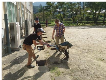
排水溝の土砂撤去
