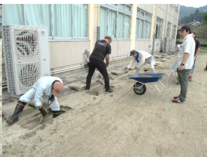
排水溝の土砂撤去
